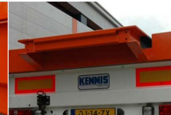
KRAANBAANOVERSTEEK AAN ACHTERZIJDE
